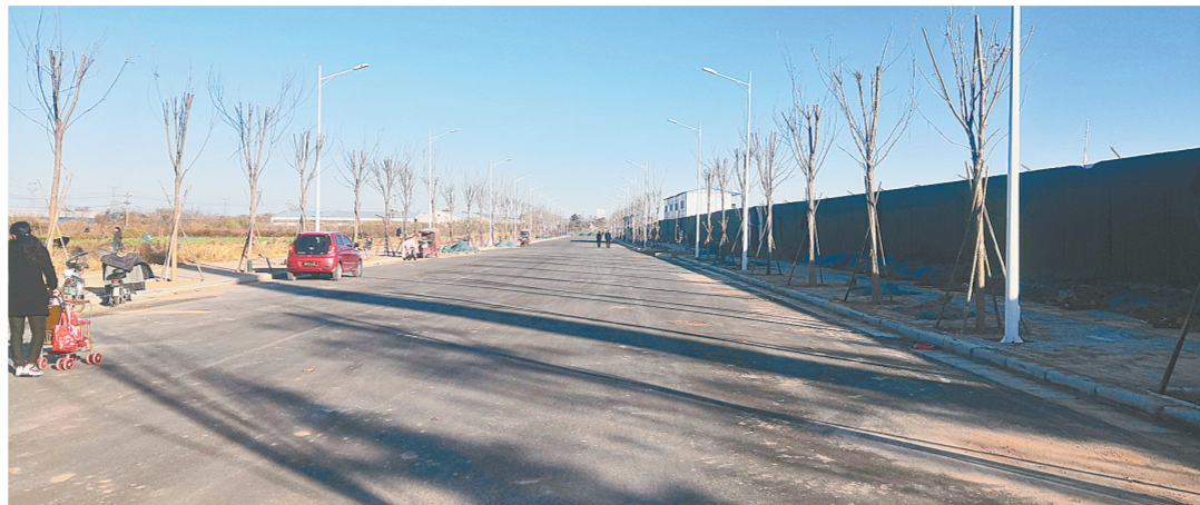
打通“断头路”，让出行难不再成为百姓“心病”。在党史学习教育中，上街区以“我为群众办实事”为落脚点，克服重重困难，着力推进“断头路”打通工程，进一步畅通城市道路“微循环”。图为湘江路东延（金华路—上街区界）建成通车后，不仅完善了新建小区的配套市政基础设施，也极大改善了周边居民的出行条件。 本报记者 武建玲 摄
