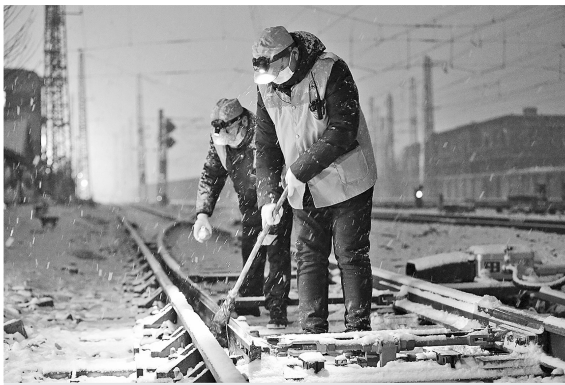
昨晚,中国铁路郑州局集团有限公司干部职工以雪为令,迅速响应,第一时间奔赴“战场”,对股道、道岔、信号机等室外行车设备进行除雪作业和设备检查,为铁路大动脉运输安全畅通提供可靠保障。本报记者 张倩 摄
