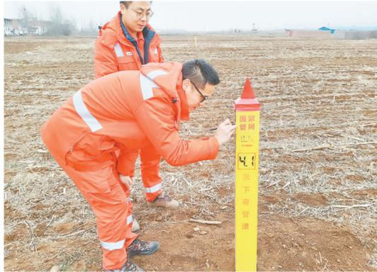
近日，国家管网西气东输郑州输气分公司启动了 2022 年春季徒步踏线活动。5 个踏线组，携带雷迪探测仪、甲烷检测仪、管道保护等“全副武装”，全员在 1415 公里的管道线上摸实情、控风险、保冬供，此次巡检预计 2 月 27 日结束。郑报全媒体记者 张华 摄
