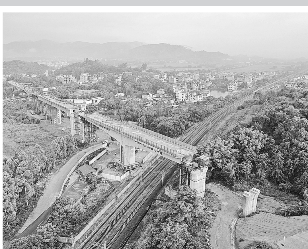
5月24日凌晨,由中铁二局集团承建的南玉高铁跨黎湛铁路特大桥成功转体57度。此次转体的桥体转体梁长99米,重5810吨。南玉高铁是南深高铁的重要组成部分,设计时速350公里。图为完成转体的南玉高铁跨黎湛铁路特大桥转体梁(无人机照片)。
