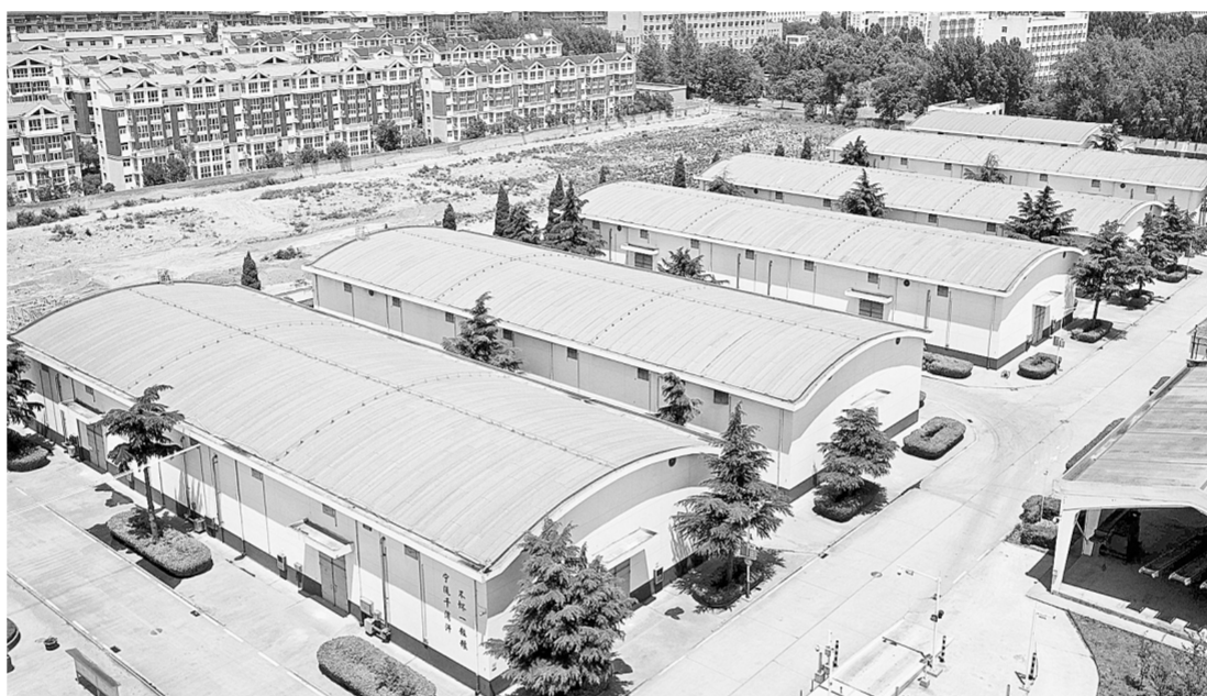
中央储备粮鹤壁直属库有限公司浚县分公司内的粮仓(无人机照片)
