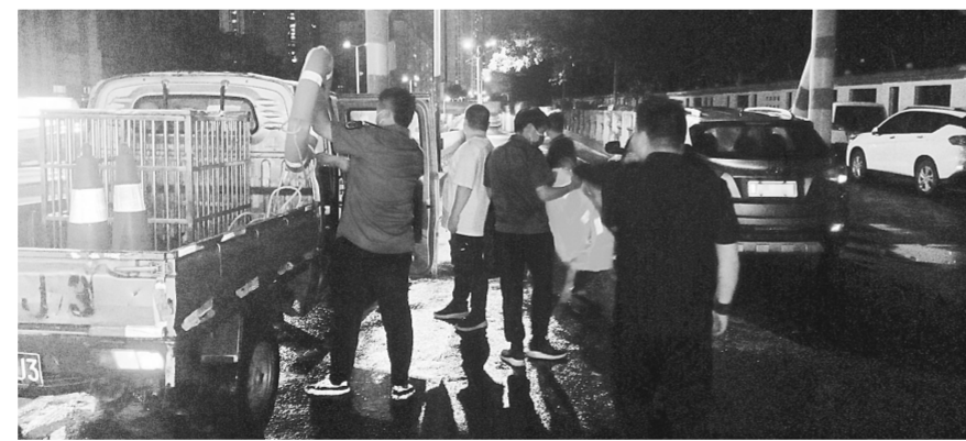
昨晚,惠济区城市管理局值守人员在兴隆辅路下穿京广铁路涵洞易积水点安置反光锥、警示标志等防汛器材。
