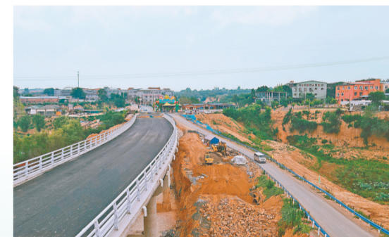
灾后重建项目——樱桃沟“坝改桥”项目工程主体建成
