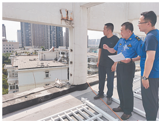
执法人员现场取证并拆除违法建设
