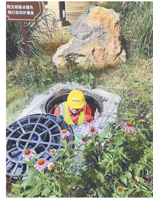
热力公司抢修现场
