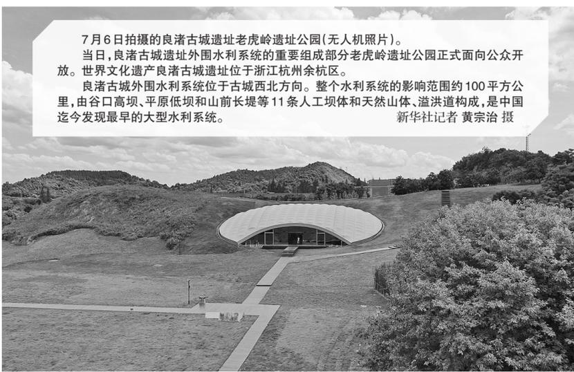
7月6日拍摄的良渚古城遗址老虎岭遗址公园(无人机照片)。当日，良渚古城遗址外围水利系统的重要组成部分老虎岭遗址公园正式面向公众开放。世界文化遗产良渚古城遗址位于浙江杭州余杭区。良渚古城外围水利系统位于古城西北方向。整个水利系统的影响范围约100平方公里，由谷口高坝、平原低坝和山前长堤等11条人工坝体和天然山体、溢洪道构成，是中国迄今发现最早的大型水利系统。新华社记者 黄宗治 摄
