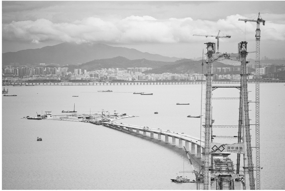
中通道伶仃洋大桥东塔、西人工岛及远处的深圳市区 新华社记者 邓华摄
