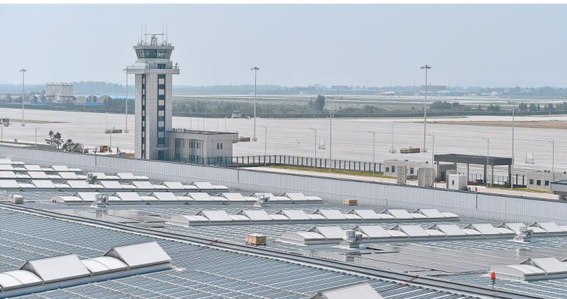
7月6日,郑州新郑国际机场三期扩建工程北货运区及飞行区配套工程竣工。据了解,该工程是郑州航空枢纽的重要基础设施,建设内容包括飞行区新建16个货机位,新建平行滑行道、机坪塔台等配套设施;货站区新建货运库、装卸货物大棚、综合楼等设施。图为7月7日拍摄的郑州新郑国际机场三期扩建工程北货运区及飞行区。
