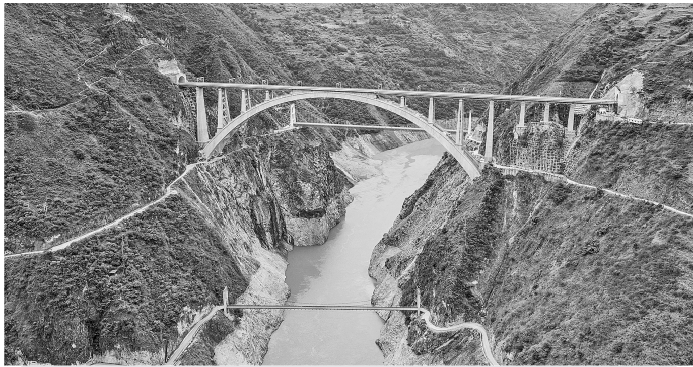
这是7月19日拍摄的大瑞铁路大保段澜沧江特大桥(无人机照片)。据中国铁路昆明局集团有限公司介绍,大瑞铁路大保段即将开通运营,云南省保山市将结束不通火车的历史。大瑞铁路全长330公里,桥隧比76.5%,是我国中长期铁路网规划中完善路网布局和西部开发重要项目,全线采取大理至保山、保山至瑞丽分段建设模式。
