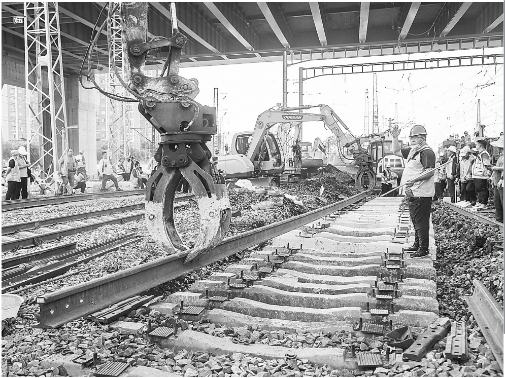
7月26日,郑州北站上到场内机器轰鸣、人声鼎沸,来自中国铁路郑州局集团有限公司郑州桥工段百余名职工利用190分钟“天窗”时间,将部分老旧木枕道岔更换为混凝土道岔,彻底消除运输梗阻。本报记者 张倩 摄
