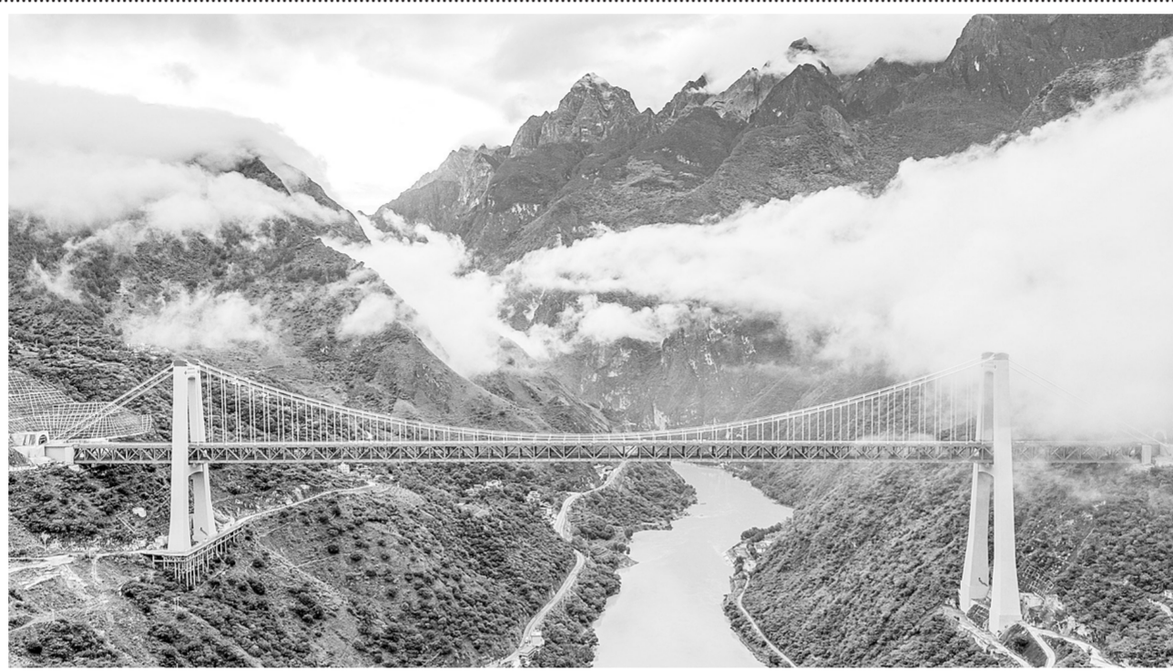
7月27日拍摄的丽香铁路金沙江特大桥(无人机照片)。大桥左边连接哈巴雪山隧道,右边连接玉龙雪山隧道。当日,丽香铁路全线控制性工程哈巴雪山隧道正洞中导洞贯通,为全隧早日贯通打下坚实基础。此外,丽香铁路重点控制性工程金沙江特大桥主体工程已全部完工,玉龙雪山隧道等19座隧道已贯通。丽香铁路全长约140公里,设计时速120公里,南起丽江市,向北跨越金沙江至香格里拉。 新华社记者 陈欣波 摄
