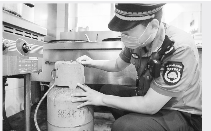
连日来,二七区城市综合执法局严厉打击瓶装燃气在使用环节中存在的违法违规行为。图为工作人员排查瓶装气安全隐患。 本报记者 刘伟平 摄
