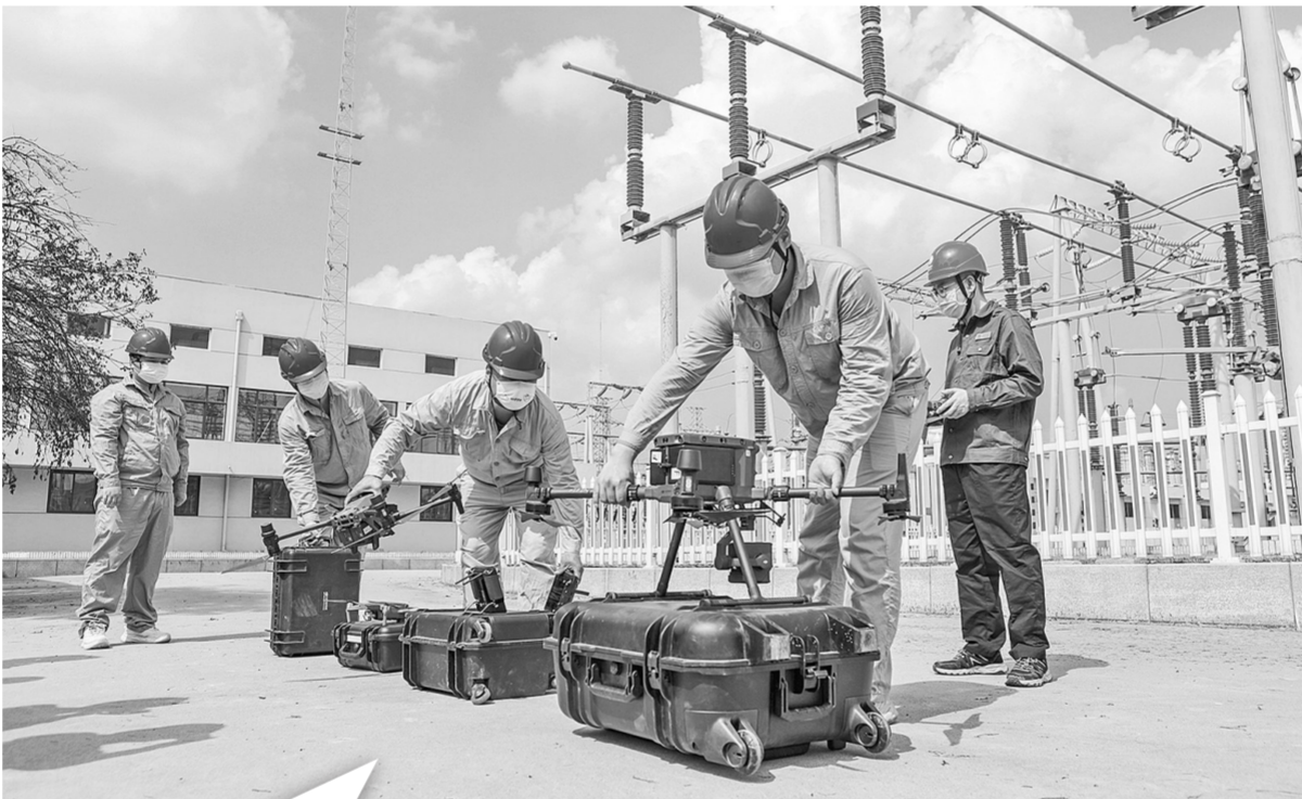
昨日,国网郑州供电公司变电运维中心工作人员操作无人机和机器人,对重点变电站进行智能巡检。
