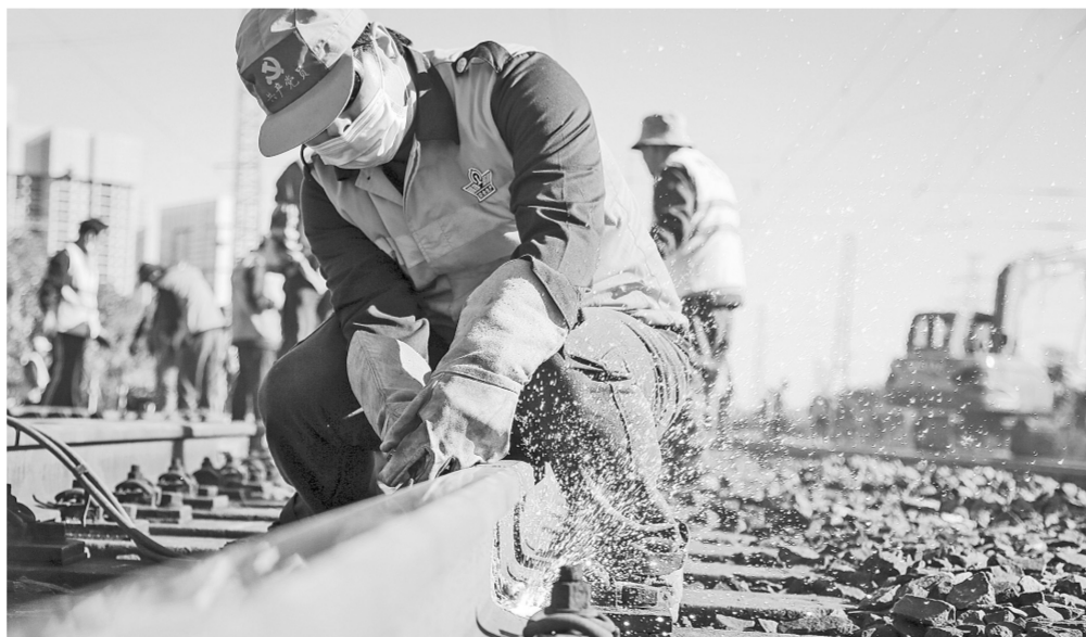
10日上午9时,随着施工命令的下达,郑州桥工段郑州综合维修车间百余名职工按部就班进入施工场地,当天他们利用210分钟的“天窗”作业时间对陇海线欢河站12号道岔进行了更换,这标志着陇海线二阶段集中修换岔施工首战告捷。 本报记者 张倩 摄
