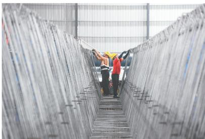
10月18日，工人在黄茅海跨海通道智慧梁场绑扎预制箱梁钢筋笼。当日，由中铁十一局承建的黄茅海跨海通道台山段预制箱梁生产突破1000片。黄茅海跨海通道智慧梁场运用智能化技术设计，使生产区占地面积由2.8万平方米降低到1万平方米，单片梁生产时间由原来的8天缩减至3.2天。该梁场预制箱梁任务共2552片，是黄茅海跨海通道项目全线最大的预制箱梁生产区。
