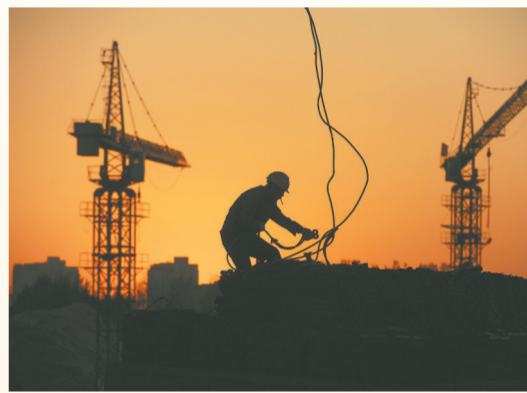
2012年10月17日,北三环东延建设工地,工人在吊装水泥板。
