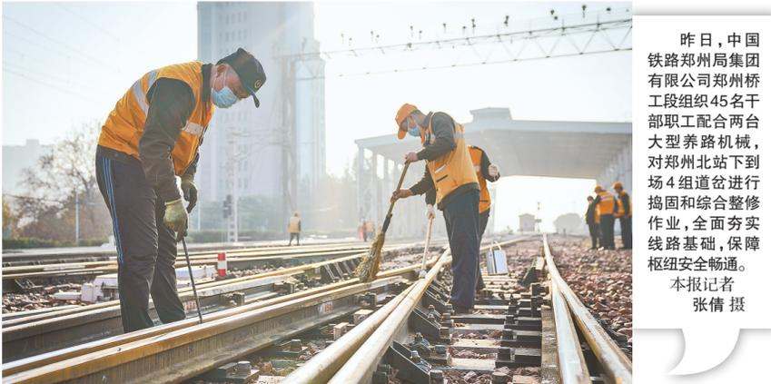
昨日,中国铁路郑州局集团有限公司郑州桥工段组织45名干部职工配合两台大型养路机械,对郑州北站下场4组道岔进行捣固和综合整修作业,全面夯实线路基础,保障枢纽安全畅通。 本报记者 张倩 摄
