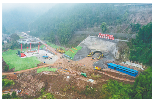
成达万高铁光明隧道施工现场 新华社发
