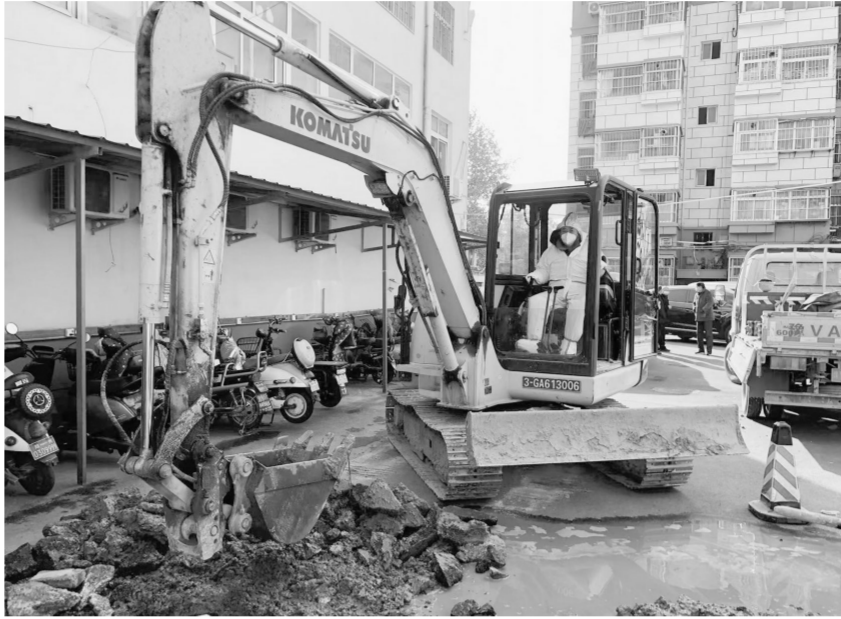
工作人员正在奋力抢修供水设施
