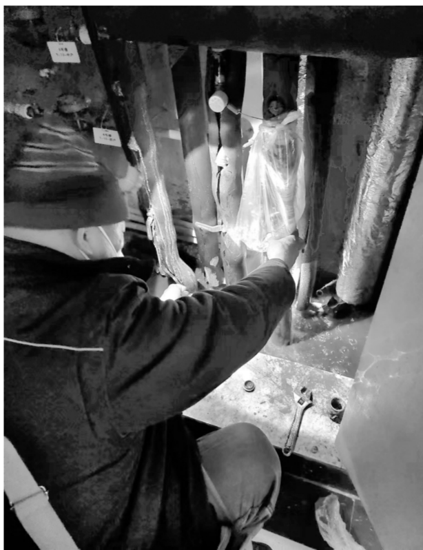
热力工作人员在检修热力设备
