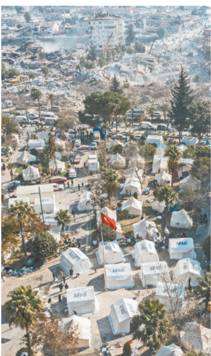
这是2月12日在土耳其哈塔伊省安塔基亚市中心拍摄的地震废墟和救援帐篷(无人机照片)。 新华社发
