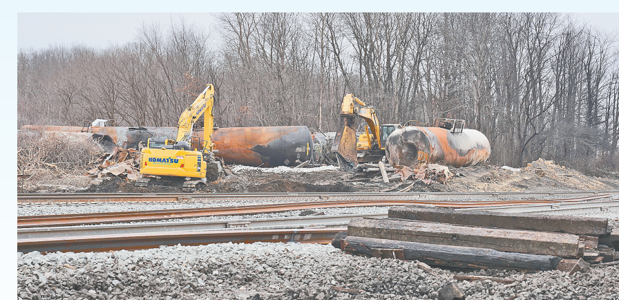
14日，在美国俄亥俄州东巴勒斯坦镇，挖掘机在事故现场处理污染土壤。新华社发
