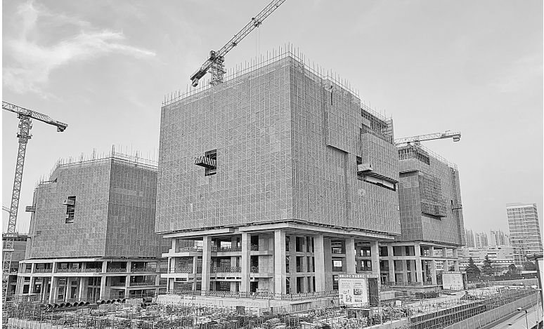
荣阳数字经济产业园项目加速建设,预计3月底前4栋建筑主体封顶
