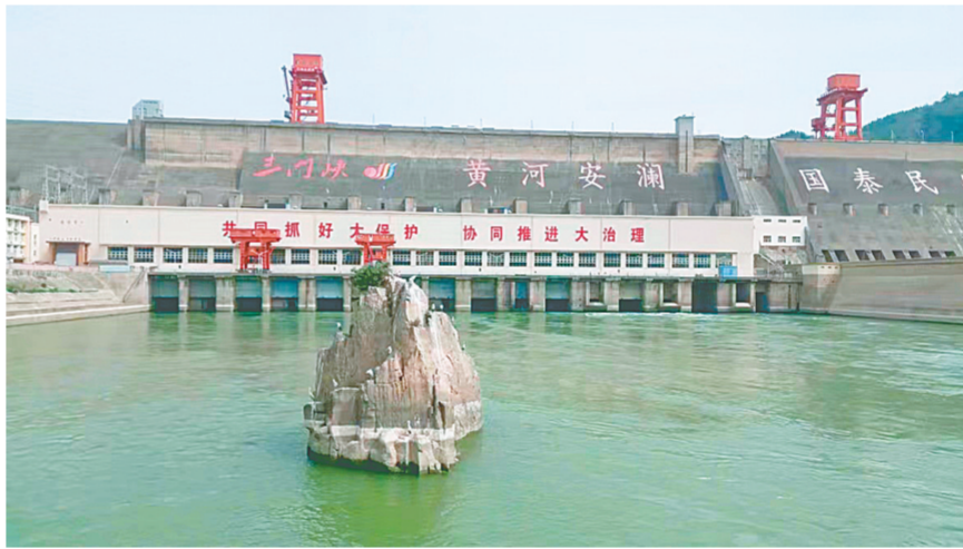
三门峡大坝在防洪、防凌、发电、供水和环境保护等方面发挥了巨大作用。三门峡日报供图
