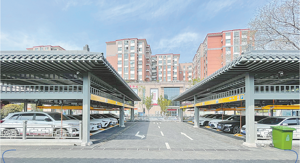
为方便前往管城区政务服务大厅办事的市民,管城区投入建设“城隍庙西侧塔湾路游园停车场”,占地面积近1600平方米,设计为机械式升降横移车位,外加地面车位共计60个。考虑到停车场与城隍庙仅一墙之隔,停车场外观采取了古典国风元素,既是停车场又是街角一景。 郑报全媒体记者 谷长乐 摄
