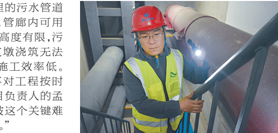
孟东方在检查管廊内支架管托焊接情况
