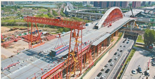
本报讯(记者 曹婷 文 周雨图)昨日,随着主桥最后一块钢箱梁精准吊装到位,上跨亚洲最大铁路编组站涉铁项目——郑州“彩虹桥”钢箱梁顺利合龙,为下一阶段大桥钢箱拱拼装、架设创造了良好条件。
