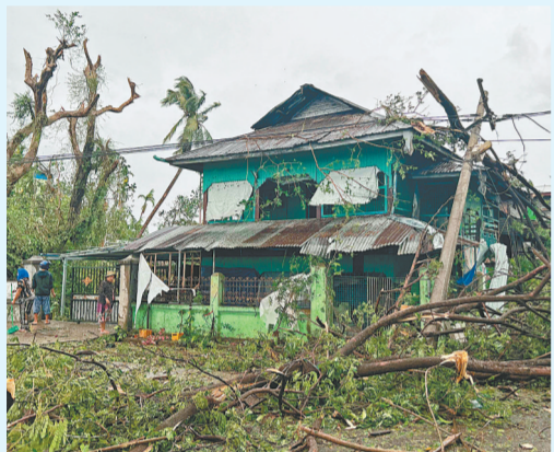
5月14日,在缅甸若开邦皎道,当地人查看受损的建筑。新华社发
