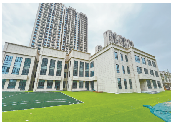
经开区祥和居实验幼儿园分园目前正在装修施工中
