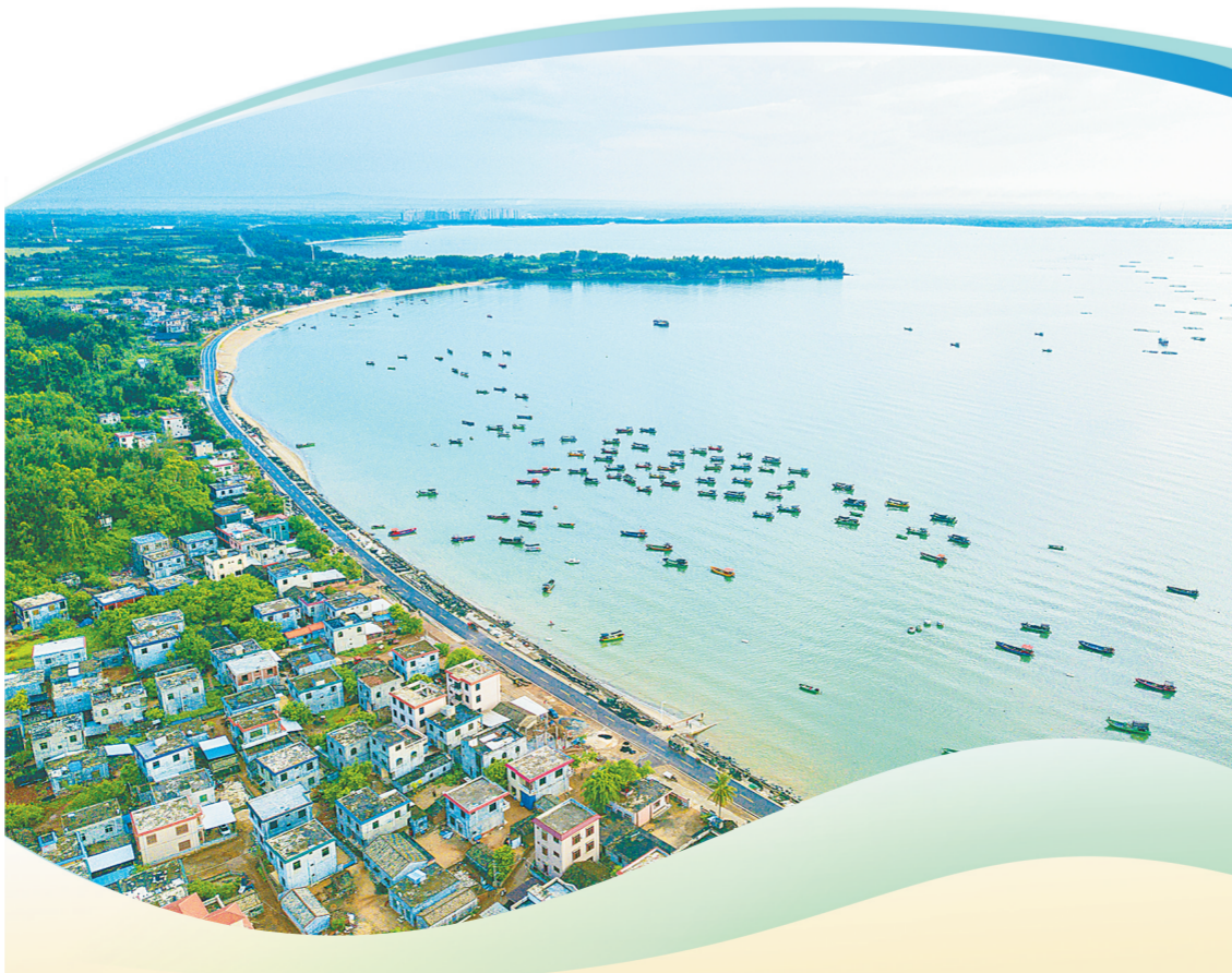
海南环岛旅游公路澄边段景色(无人机照片,6月25日摄)。近日,海南环岛旅游公路主线路基建设完成,正在进行大桥、机电和绿化等施工。海南环岛旅游公路是建设海南自贸港和创建国际旅游消费中心的先导性重大基础设施项目,该公路主线总里程988.2公里,串联沿途特色海湾、海角、特色小镇和旅游景区、滨海度假区等。新华社记者 蒲晓旭 摄
