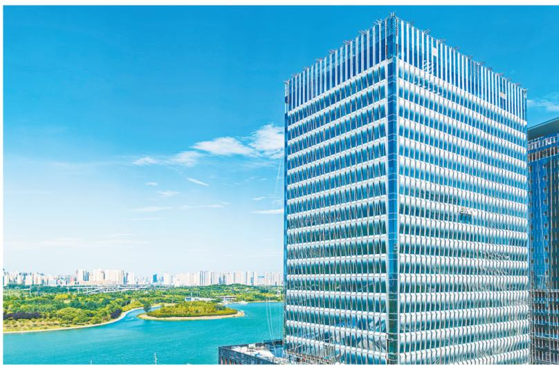
湖金融岛是郑东新区国际化区域金融中心建设的主承载区,目前,龙湖金融岛外环已有11栋楼宇实现主体封顶。龙湖金融岛外环20号楼外立面由1967块大玻璃幕墙幕墙环绕而成,室内外视线无任何遮挡,实现了建筑内部与室外园林绿化、滨水景观充分融合。其中首层采用了大玻璃超幕墙,每块重达1.5吨,尺寸高10.5米、宽1.8米,是全市目前最大的玻璃幕墙之一,随阳光、月光的变化,玻璃幕墙在不同角度观察呈现出不同的色调,引来了众多市民前来拍照打卡。
