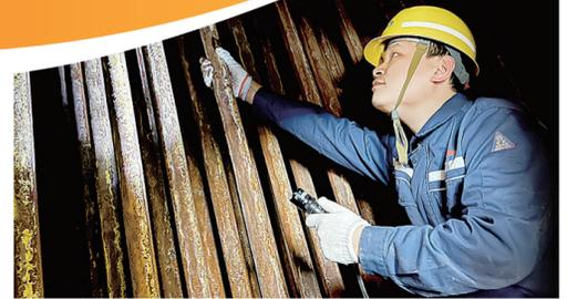
工作人员在燃气锅炉炉膛内进行夏季维修保养
