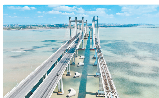
9月28日,我国首条时速350公里跨海高铁——福厦高铁正式开通运营。开通后,福州至厦门的列车运行时间从现在的2小时左右缩短至1小时以内。图为福厦高铁泉州湾跨海大桥。新华社记者 姜克红 摄
