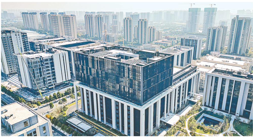
新启用的安图生物诊断仪器产业园，单体面积达15万平方米的体外诊断仪器研发生产中心已经部分投入使用 郑报全媒体记者 马健 摄
