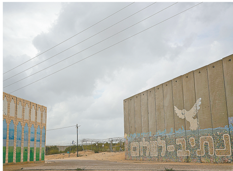
这是11月19日拍摄的以色列沿加沙地带修建的隔离墙 新华社记者 陈君清 摄
