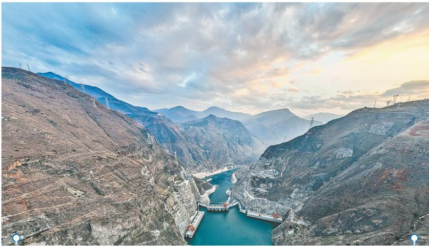
乌东德水电站一景(无人机照片，12月22日摄)。乌东德水电站位于云南省昆明市禄劝县和四川省凉山州会东县交界的金沙江河道上，是实施“西电东送”的国家重大工程。电站共安装12台单机容量85万千瓦水轮发电机组，总装机容量1020万千瓦。截至12月22日，乌东德水电站累计发电量达1230.87亿千瓦时。
