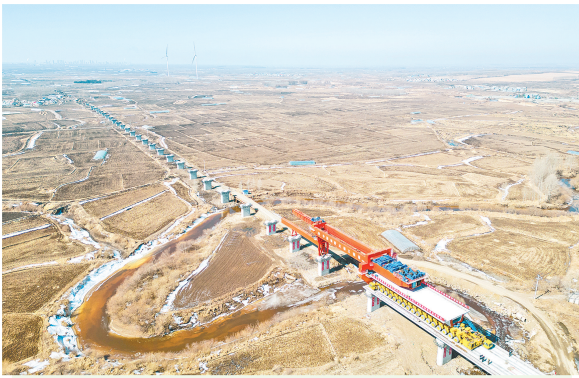
3月25日,在哈伊高铁安邦河特大桥施工点,中国铁建大桥工程局集团有限公司的工作人员在进行架梁作业(无人机照片)。哈伊高铁是我国“八纵八横”高铁网京哈—京港澳通道的延长线,起自哈尔滨市,途经绥化市,南至伊春市,正线全长318公里,设计时速250公里,是我国在建纬度最高、全线所处地区全年温差最大、首条穿越多年岛状冻土区的高速铁路。
