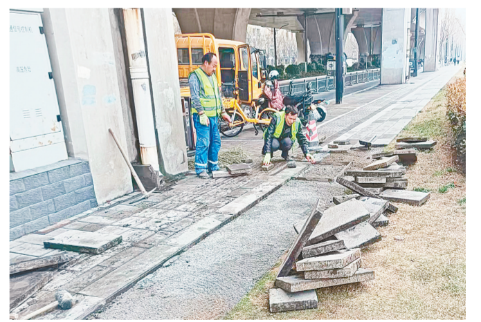
环卫工人整修人行道
