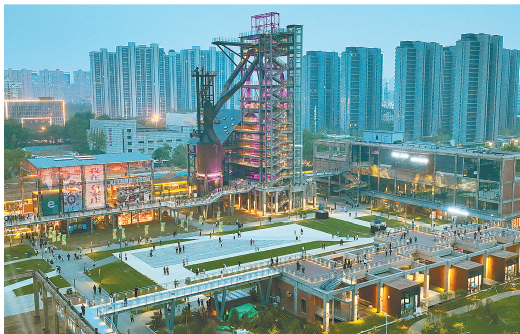
4月27日,市民在河北省石家庄市工业遗址公园游览(无人机照片)。近日,河北省石家庄市工业遗址公园对公众开放。该公园所在地曾是石家庄市钢铁厂。石家庄市对其进行改造再利用,以“存旧纳新、绿动未来”理念,将保留的原址废弃高炉、部分厂房和设备改造成为工业遗址公园景观性建筑,实现从“工业锈带”到“生活秀带”的转变,打造成为石家庄市工业历史文化的独特地标。
