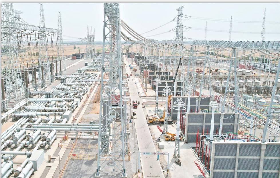
6月4日,工人在位于河北省新河县境内的榆横至潍坊1000千伏特高压交流输电工程邢台变电站扩容工程建筑工地施工。近日,位于河北省新河县境内的榆横至潍坊1000千伏特高压交流输电工程邢台变电站扩容工程建设稳步推进。据介绍,陕西榆横至山东潍坊1000千伏特高压交流输电工程邢台变电站是京津冀鲁负荷中心的重要枢纽。扩容工程新增2组3000兆伏安变压器等设备,竣工投产后将有效提升送电能力、保障电网安全,助推经济发展。 新华社记者 杨世尧 摄
