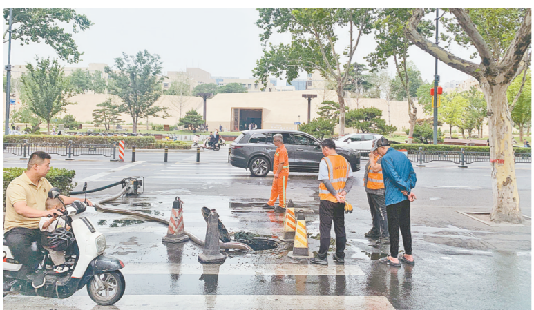
吸污车进行抽水作业
