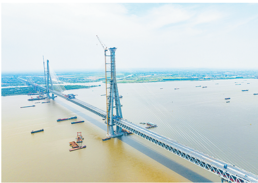
6月9日拍摄的常泰长江大桥建设作业现场(无人机照片)。当日,随着主航道桥钢桁梁合龙段焊缝焊接完成,常泰长江大桥顺利合龙。历时5年,这座世界最大跨度斜拉桥实现全线贯通,常泰长江大桥连接江苏省常州、泰州两市,预计明年4月底前具备通车条件。新华社发
