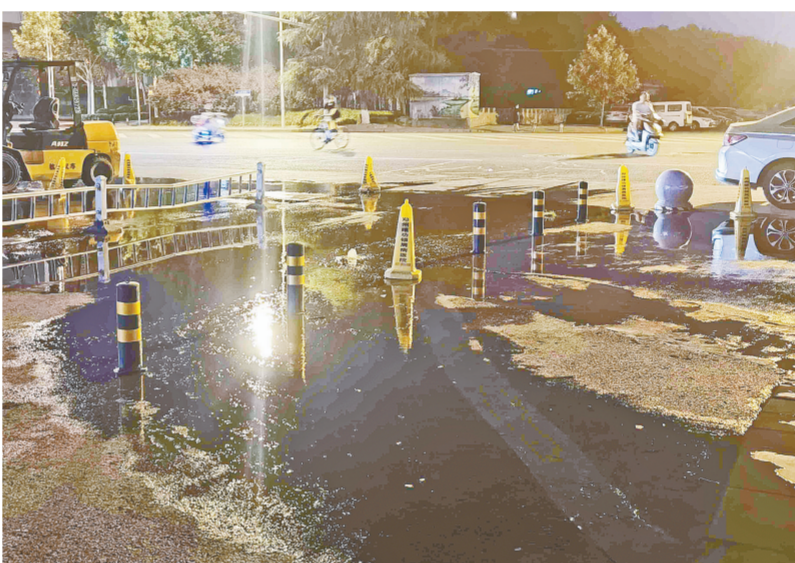
窨井堵塞向外翻出大量污水和污物
