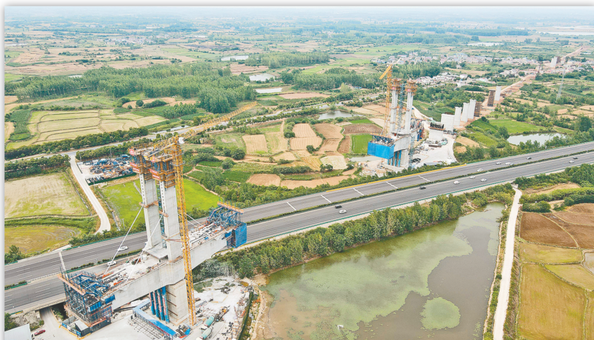
6月18日，由中国铁建大桥局承建的新建上海至南京至合肥高速铁路跨沪陕高速公路特大桥主桥塔柱顺利封顶，为后续施工奠定基础。新建上海至南京至合肥高速铁路是国家中长期铁路网规划“八纵八横”中沿江通道的重要组成部分，是江北沿江城市与南京都市圈、上海都市圈快速直达的快捷通道，承担沿江通道主要路网客流、沿海及京沪通道部分直通上海客流的运输。
