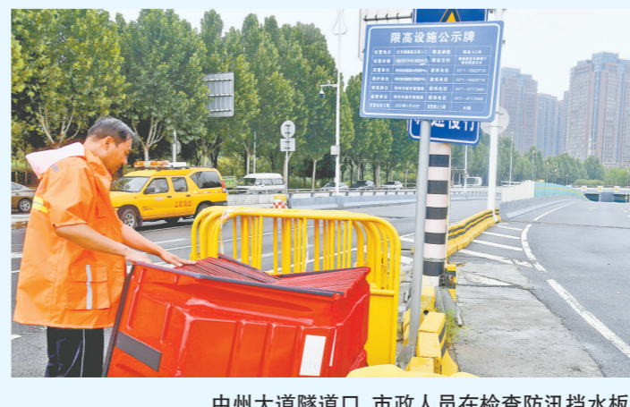
中州大道隧道口,市政人员在检查防汛挡水板
