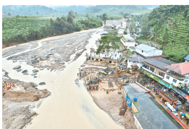
7月31日,在印度喀拉拉邦瓦亚纳德,救援人员准备搭设桥梁。
