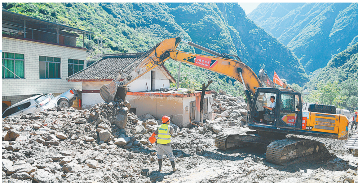
8月5日，在四川甘孜州康定市姑咱镇日地村，救援人员操作机械疏通国道318线(无人机照片)。新华社记者 刘坤 摄
